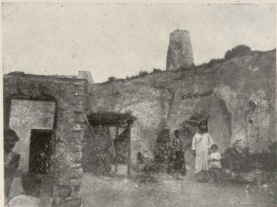
FIGURA 16.—Sin necesidad de recurrir a prolijas descripciones, pronto se echa de ver, en esta fotografía, el típico vivir hipogeo de los habitantes de Ontígola, localidad próxima a Aranjuez, cuyas viviendas subterráneas, en medio estepario, se hallan excavadas en un conglomerado terciario.
