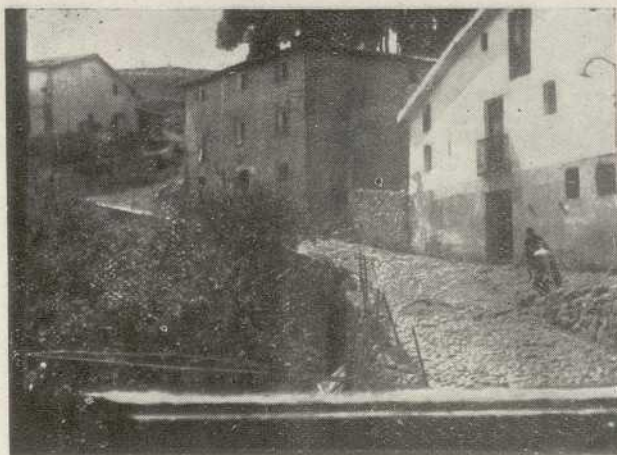
FIGURA 12. - Detalle de las casas de la calle de Campillo (Torrecilla en Cameros), con elementos constructivos castellanos y vascos. En primer plano, a la derecha, una casa en cuya fachada hay empotrados dos cuernos de vaca para atar las caballerías. FOTO DEL PAN.
