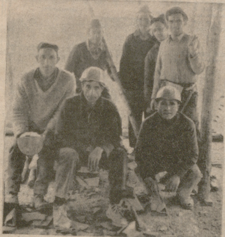
Los trabajadores que llevan a cabo la construcción del Colegio Menor de S. F. Es el barrio que progresa
