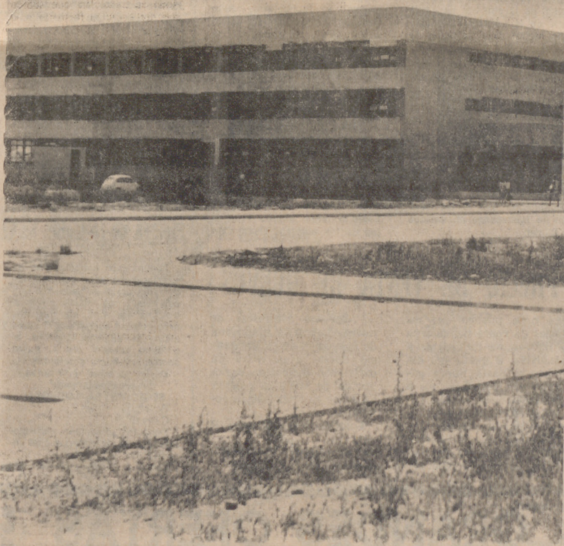
El Instituto de Enseñanza Media ubicado en el terreno de Lobete funciona ya para satisfacción de todos. Se han trazado las calles y enseguida las hormigoneras y grúas comenzarán su otra función: levantar viviendas.
