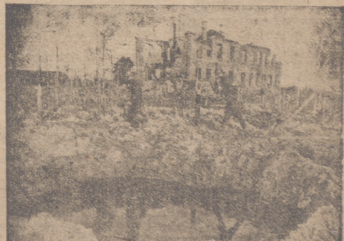
Ruinas de Voronej, la ciudad que a pesar de los repetidos ataques bolcheviques, sigue en poder de las fuerzas alemanas.
