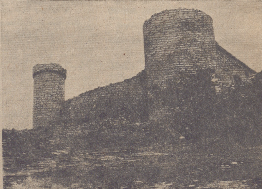
Una de las fachadas. Nótese la mano del hombre en la destrucción.
