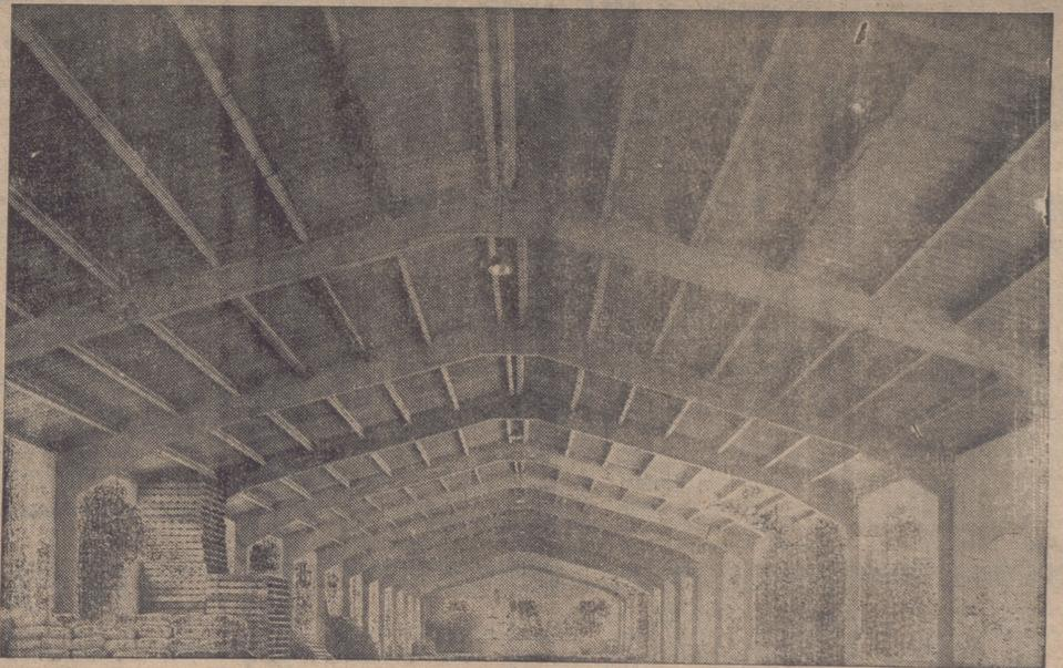
Pórticos de 8 a 20mts. de anchura y de 2'50 a 6 mts. de altura en pilares; enteramente de hormigón, incluidos pilares,
