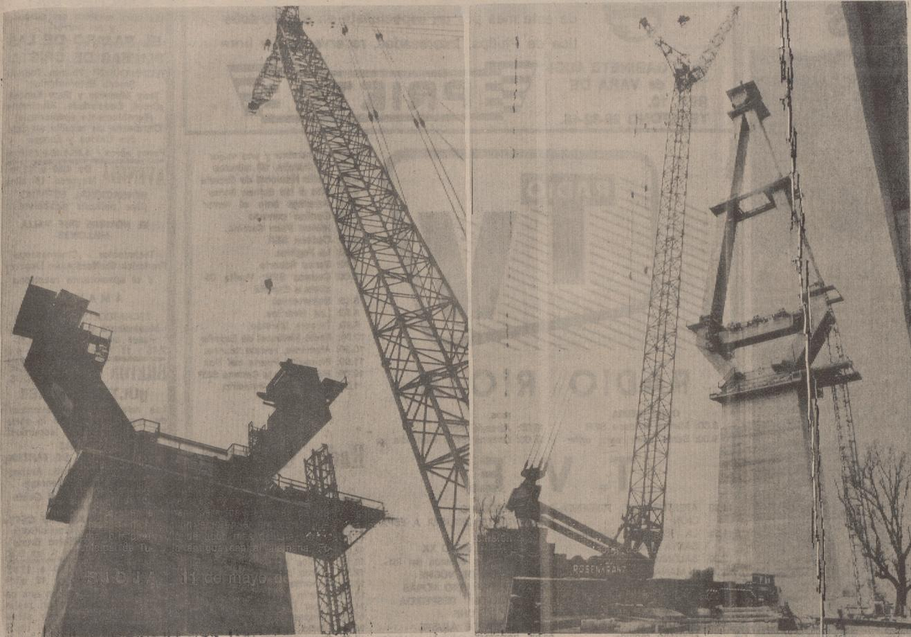
HAMBURGO. (DaD). — Por tercera vez entró en acción la grúa sobre camión más grande del mundo, construida en la República Federal de Alemania. Sólo para su montaje, los montadores requirieron cada vez más de dos semanas. Se necesitó la grúa en Hamburgo para izar y colocar los elementos de construcción de acero, prefabricados, sobre los pilares de hor-
