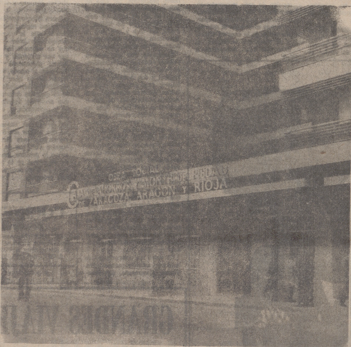
FACHADA DE LA NUEVA OBRA SOCIAL EN LOGROÑO
