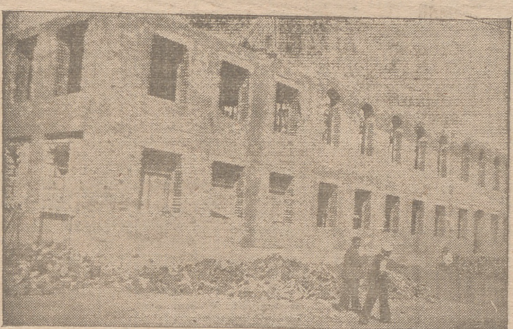
Estado de las obras del Colegio-Seminario de los PP. Agustinos, en la carretera de Soria
