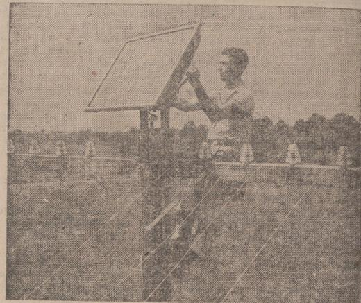
Un celador ajusta en lo alto de un poste la batería solar inventada por la Compañía Telefónica Bell para hacer las primeras llamadas utilizando energía generada por el sol. Esta batería proporciona actualmente energía eléctrica para un servicio telefónico rural en el Sur de los Estados Unidos.
