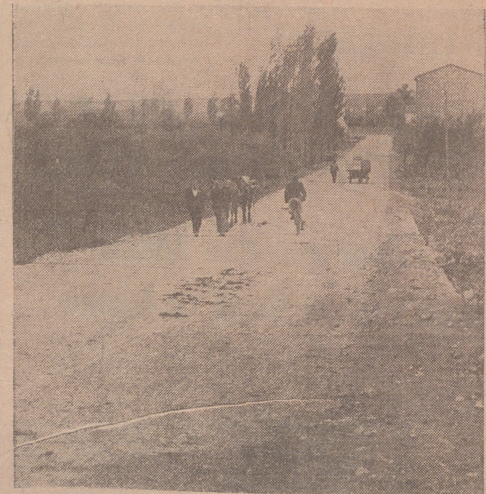
Empalme de la Carretera de Sorín, que da entrada al pueblo de Lardero, después de la reforma.
