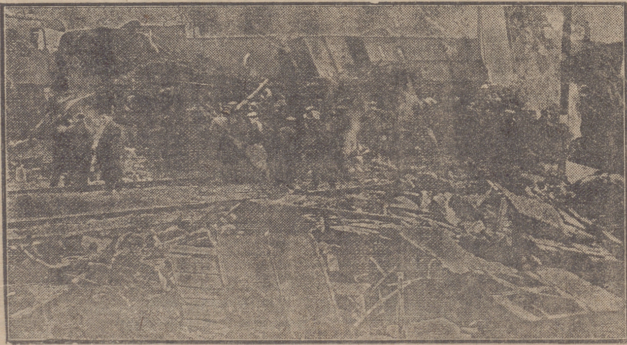
UN ASPECTO DE LA ESPANTOSA CATASTROFE FERROVIARIA DE LAGNY (FRANCIA)
