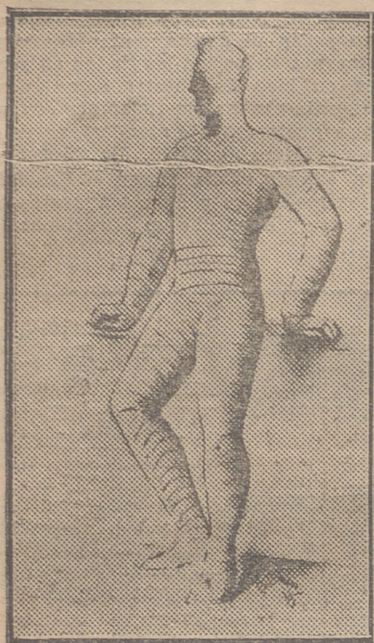
Dibujo que muestra de qué modo irá vestido el cuerpo del astronauta, para compensar la falta de presión atmosférica, y evitar la hinchazón. Fot. Agencia Gráfica
