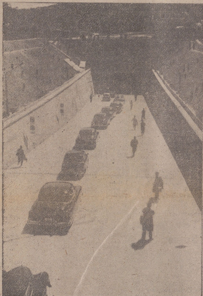
Una de las grandes obras efectuadas por el Japón en nuestros días: el túnel Kannon. Tiene un piso para vehículos y otro para peatones. Une dos islas y se sumerge cincuenta y cuatro metros.
