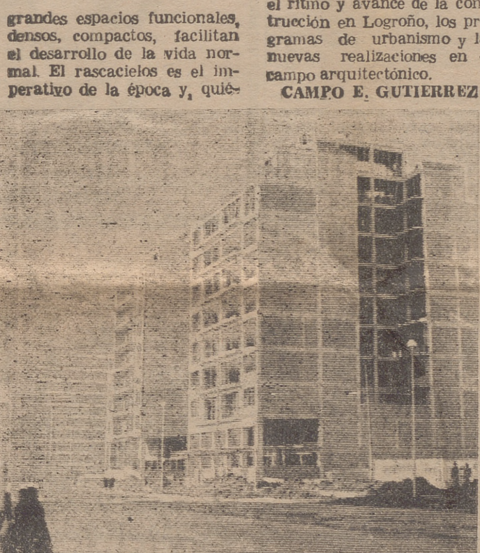
En pleno centro de Logroño, sobre la Gran Vía, la fiebre constructora es sinónimo de progreso. Las edificaciones tienen un promedio de siete plantas como éstas que aparecen en primer término. (Foto "Albe")
