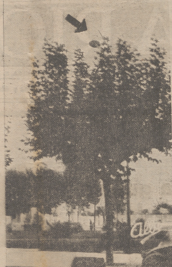
La fotografía es elocuente: la flecha indica el lugar donde se encuentra la lámpara. Debajo, el árbol que tapa toda la luz e impide que ésta llegue a la calzada.
