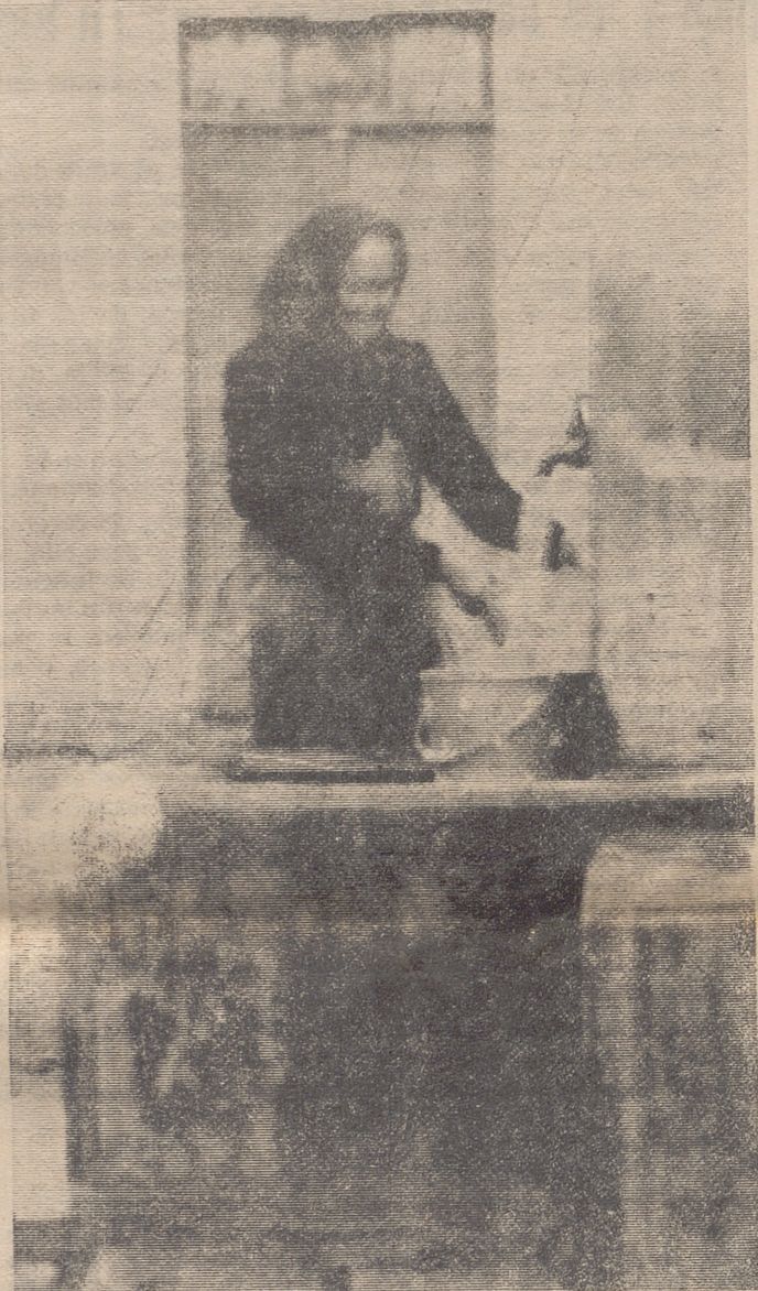
Un problema: la falta de agua.
