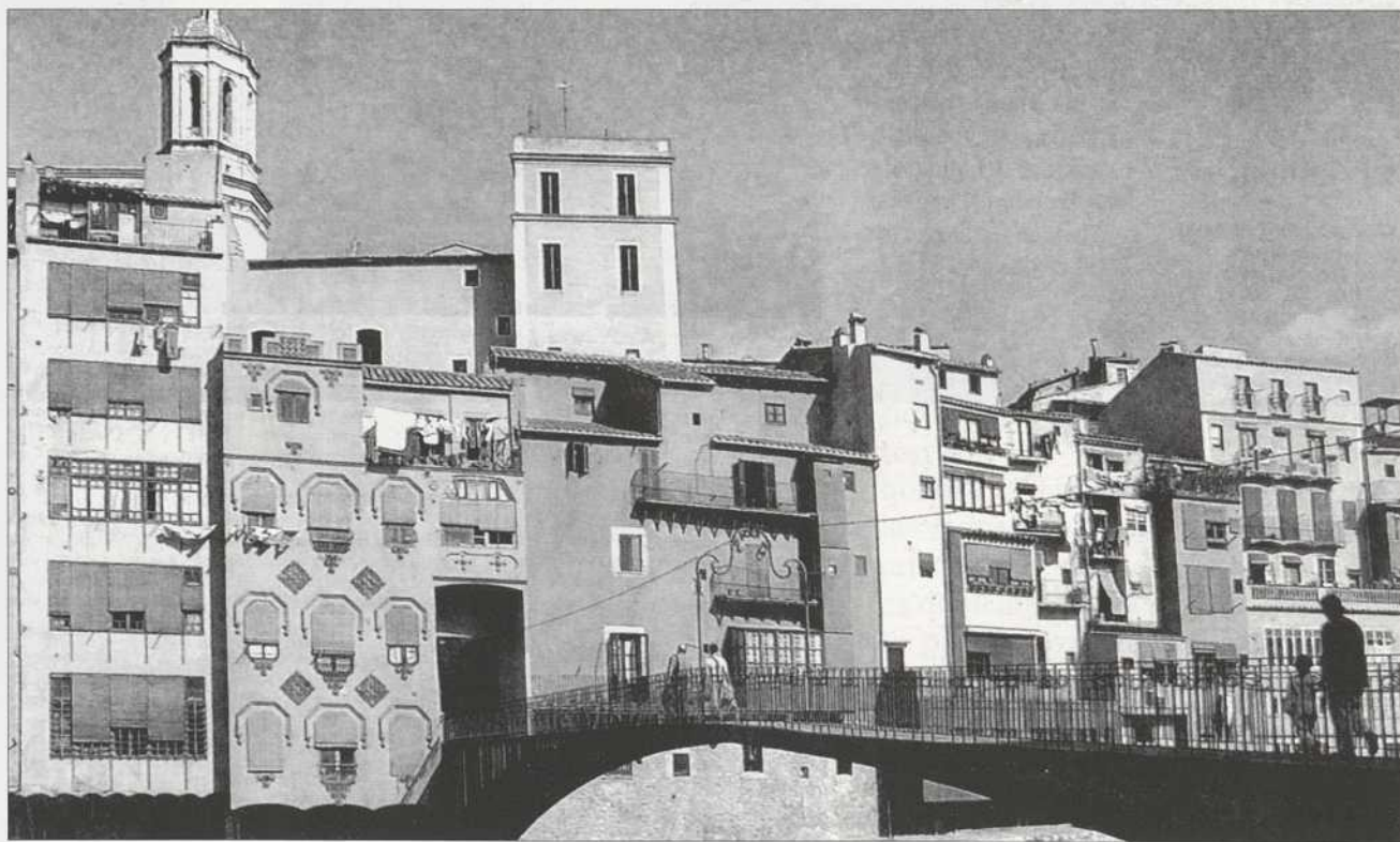
Puente de Gómez. Gerona.
