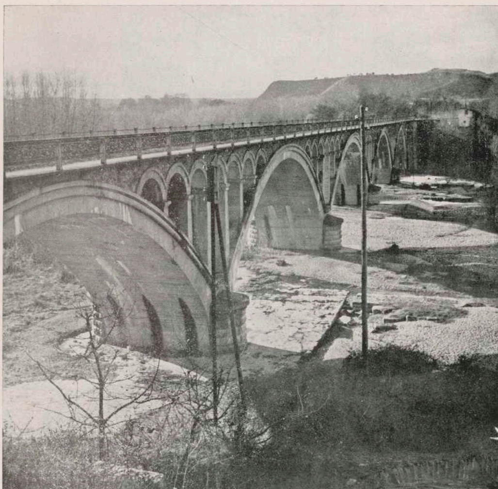
Nuevo puente del ferrocarril
