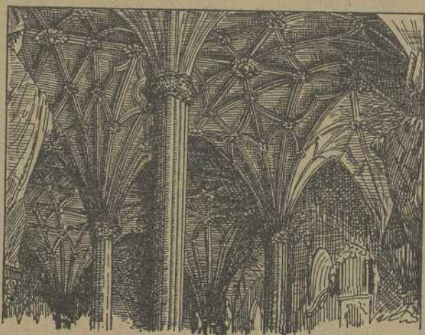
Fig. 208.—Columnas y bóvedas ojivales.—Catedral de Barbastro. viértese esta forma desde el siglo XIII. El arranque de todo el conjunto de nervios sobre la columna semeja una palma que extiende sus ramos en todas direcciones.
