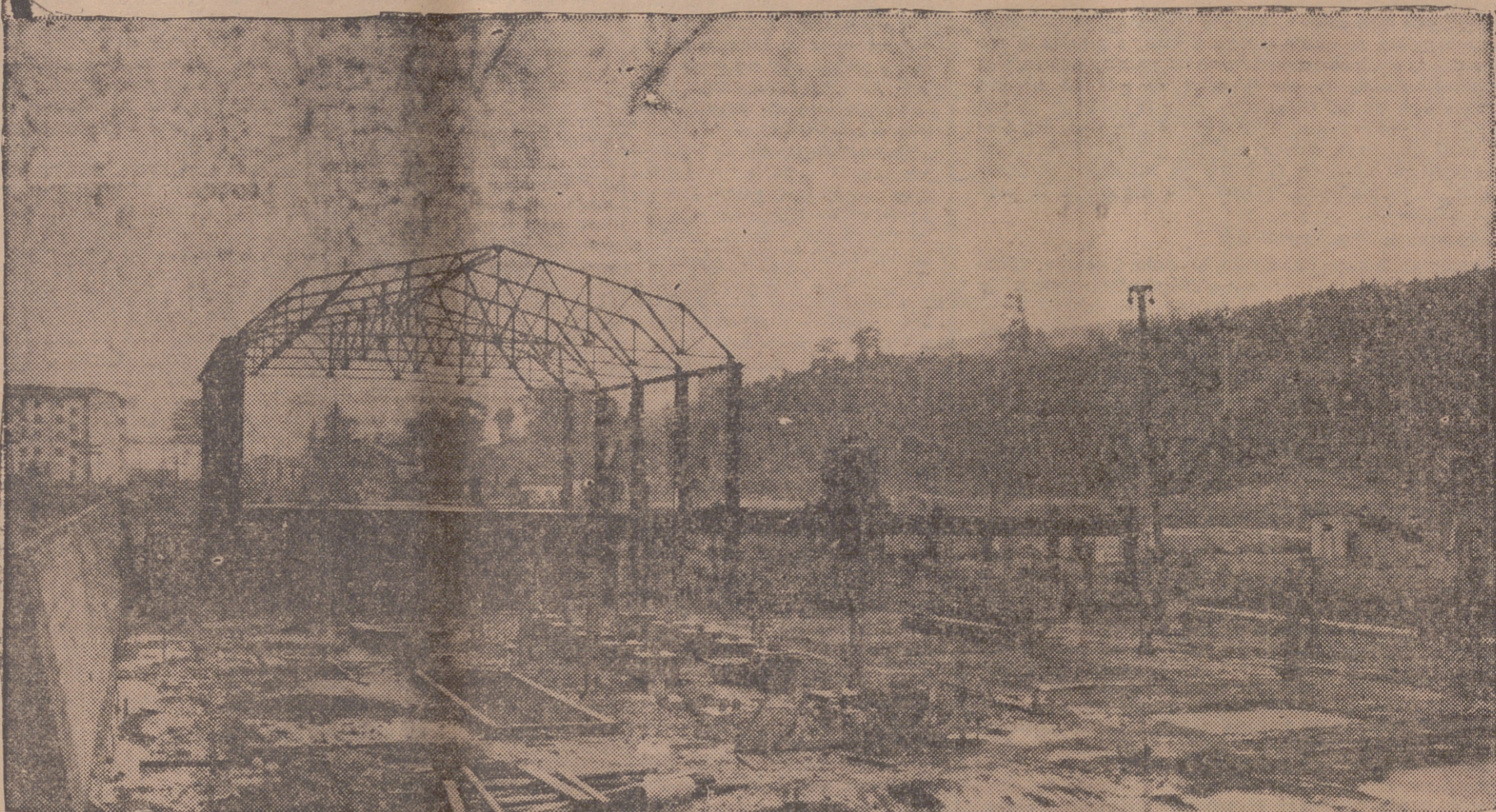
ESTADO ACTUAL DE LAS OBRAS DEL PRIMER HORNO
