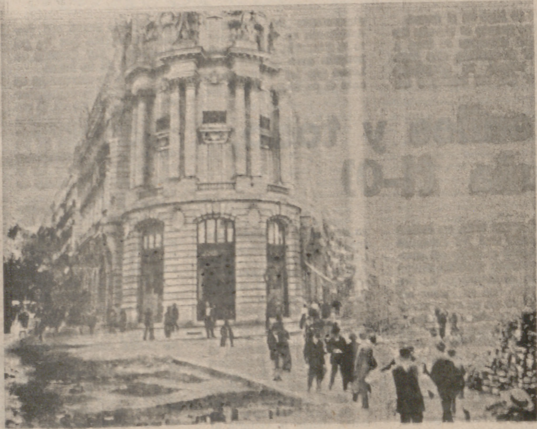
Vemos aquí el derribo del edificio de «El Fénix, primer paso para la construcción de la actual Gran Vía madrileña.
