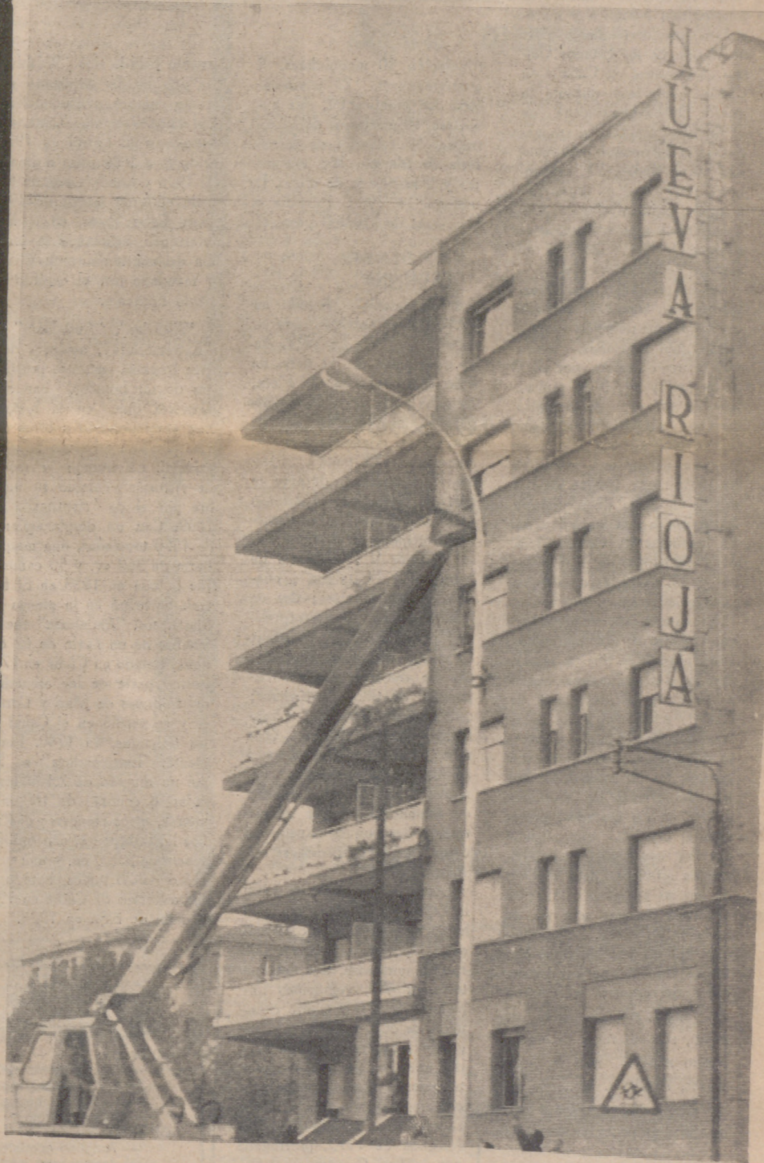
Ya están en pie las farolas de Vara de Rey. Luz para uno de los principales accesos a la capital. Resulta espectacular la operación de montaje, tal como se demuestra la foto. La cámara de Herce recoge precisamente el momento en el que se coloca el brazo situado al lado mismo de nuestra Casa. (Foto HERCE)
