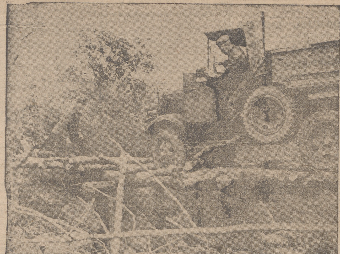
Un momento bastante peligroso es este de atravesar el ligero puente que ha sido construido por los zapadores alemanes, para sustituir el que destruyeron los soviets, con este camión. Sin embargo, fué atravesado sin ningún percance.
