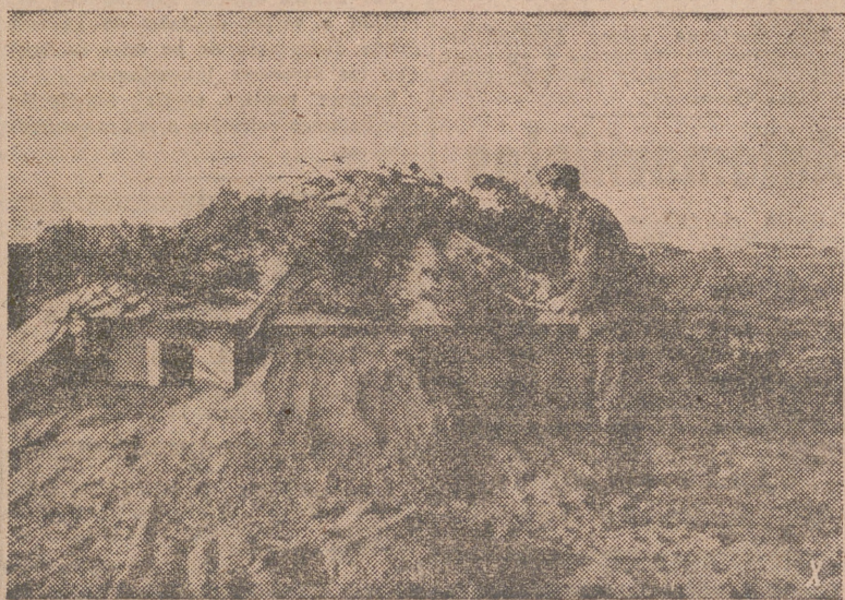
Curioso tipo de tienda de campaña finlandesa, construida, excepto su parte superior, bajo tierra
