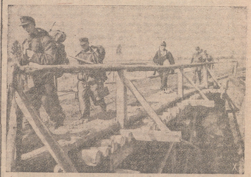
Sólo en horas, los ingenieros acaudalados sustituyen con este sólido y amplio puente de madera el que en ese mismo lugar ha desaparecido por efecto de un bombardeo. (Foto Orbis)
