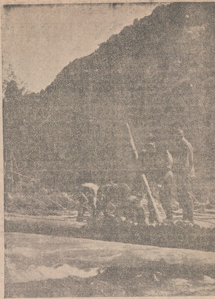
LA CONSTRUCCION DE UN PUENTE AUXILIAR DE GUERRA EN EL SECTOR DEL KUBAN. CON LA AYUDA DE TRONCOS PRONTO SERAN TERMINADOS LOS TRABAJOS Y SE PODRA ATRAVESAR EL ARROYO. (Foto Orbis)
