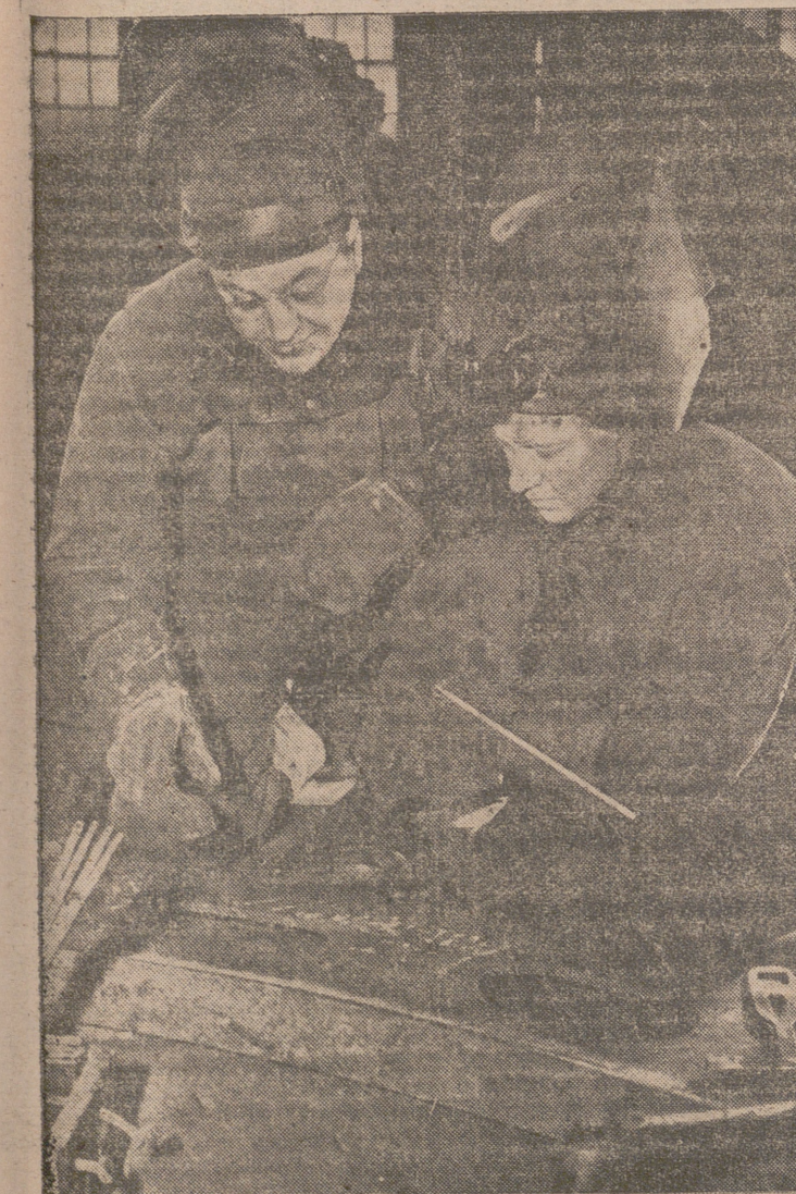
Un matrimonio norteamericano comprueba la soldadura que han hecho en uno de los astilleros donde colaboran en la construcción de submarinos para la Armada norteamericana.
