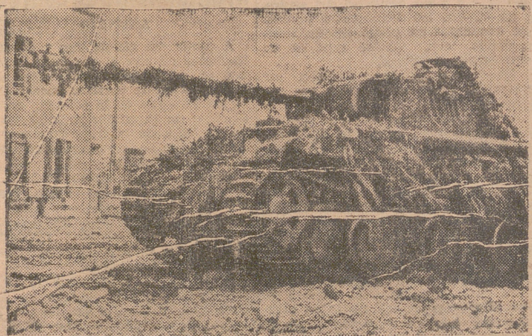
Un tanque «Pantera» toma posición en una calle, entre las casas derruidas. — (Foto Orbis)
