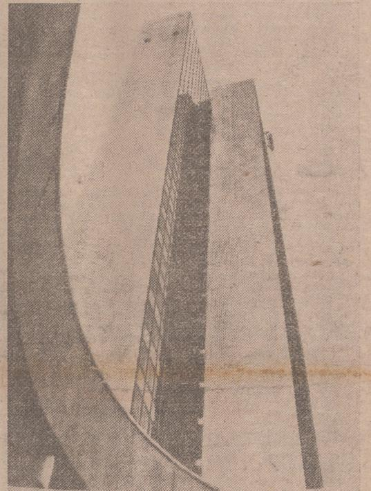
En Düsseldorf (Alemania) se levanta la impresionante estructura de 95 metros de altura de la casa de Thyssen. Sus 24 pisos están contruidos de acero, aluminio y cristal. El acero reviste los costados del edificio, y tubos de acero también han sido empleados como pilares. Con estas edificaciones los urbanistas alemanes ven una posibilidad de edificar en las grandes ciudades ante la escasez de terreno.—(Foto Fiel).
