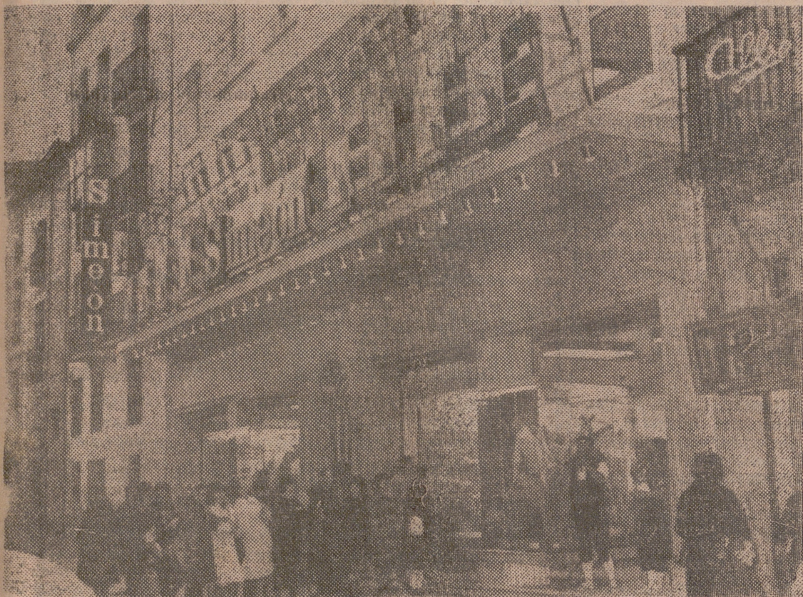
Una vista del exterior del establecimiento de "SIMEON" Almacenes de San Pedro, S. A.
