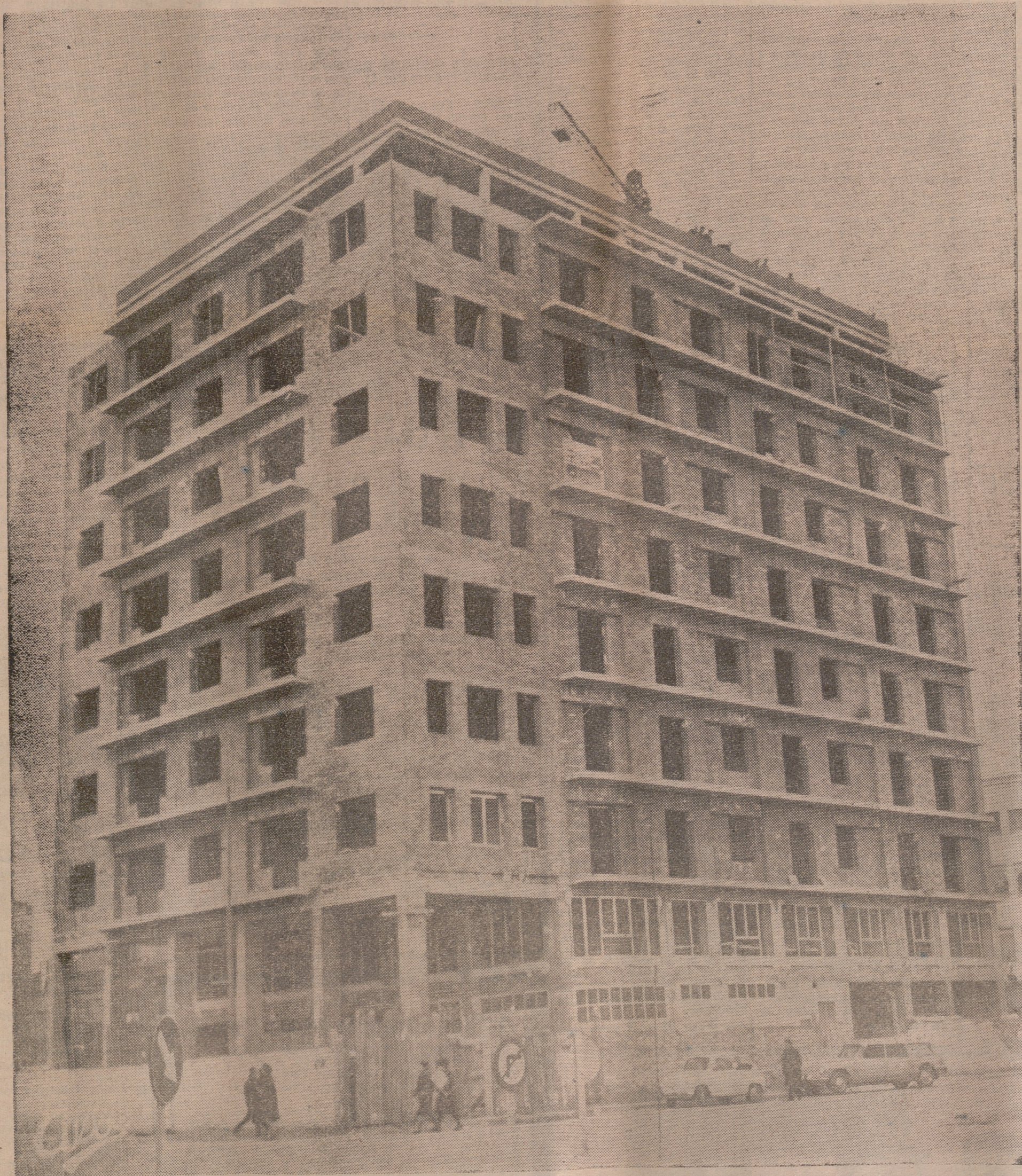
Vista exterior del edificio que esta empresa está construyendo en la nueva Gran Vía de Gonzalo de Berceo
