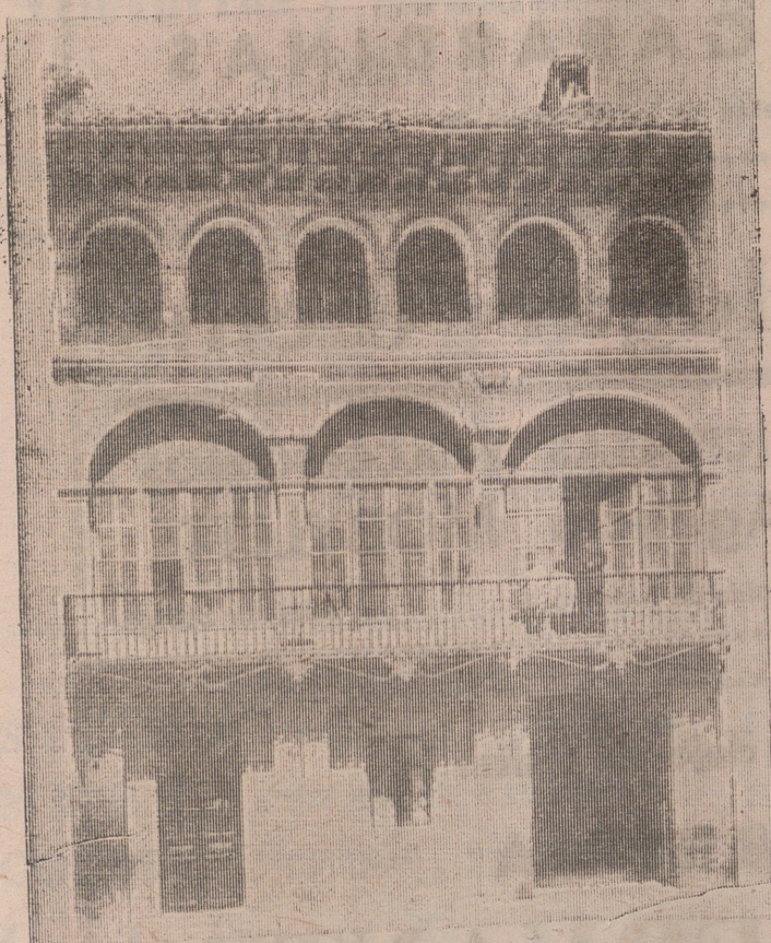
Edificio, ya desaparecido, donde antiguamente estuvo instalado el Ayuntamiento de nuestra capital, popularmente conocido por «Casa del Portalón». Estuvo emplazado en el lugar que hoy ocupan el edificio del Banco de Aragón y calle de Juan Loo.
