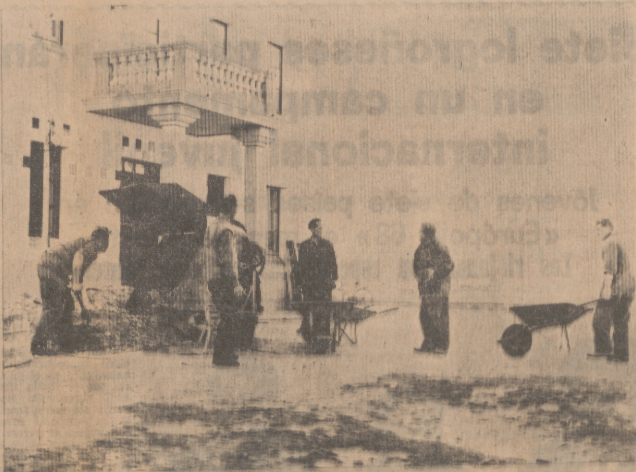
El Centro de Subnormales «Virgen de la Esperanza» está en obras. — (Foto Payá).
