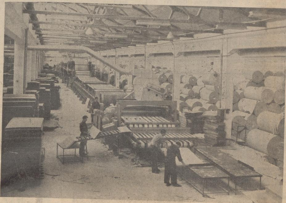
Nuevo tren de ondulación de la Casa "Peters", de Hamburgo, para la fabricación de cartón ondulado. Esta instalación tiene una longitud de 120 metros.
