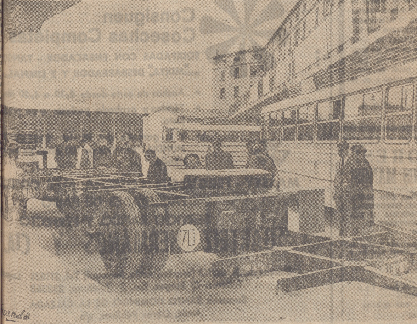
CHASIS DE AUTOBUS "BARREIROS" A. E. C., MODELO A 501-B, INTERURBANO, PRIMERO DE ESTA SERIE, ADQUIRIDO POR DON JOSE LOPEZ EZQUERRO
