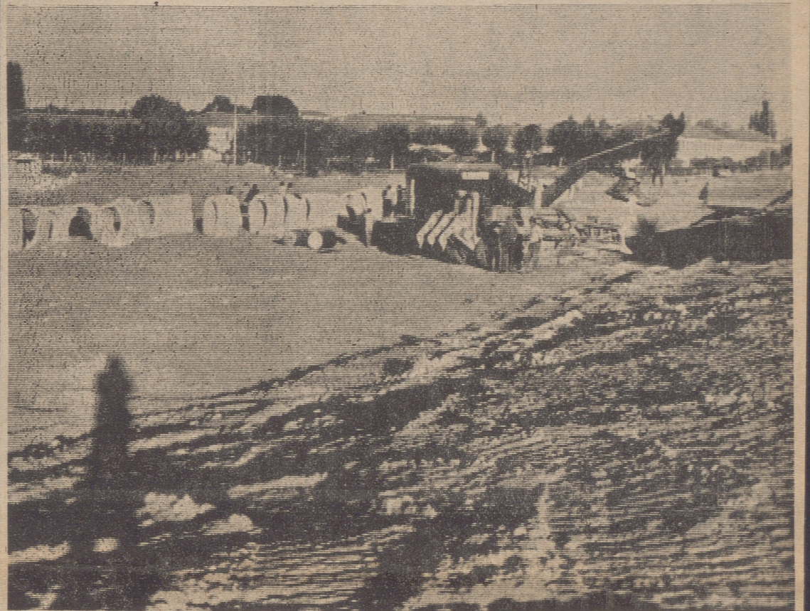
El polígono residencial de Lobete inició sus obras de explanación, saneamiento, distribución y pavimentación. Las obras llevan un buen ritmo. En la fotografía de "PATA" podemos observar una de las grandes máquinas en el momento de abrir la zanja que cubrirá las tuberías.
