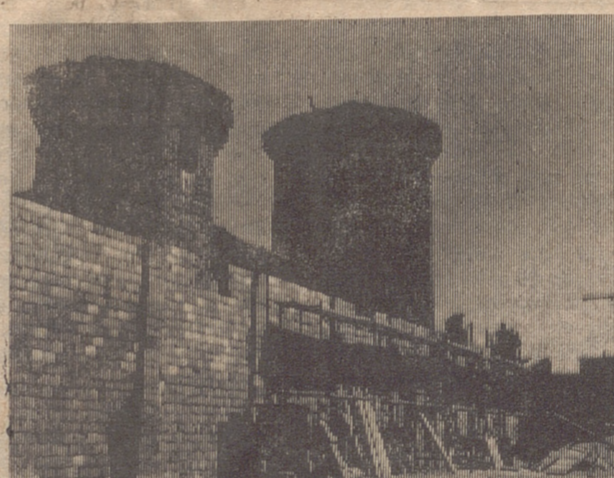
Aspectos del granero en construcción, en el que intervinieron todos los socios.
