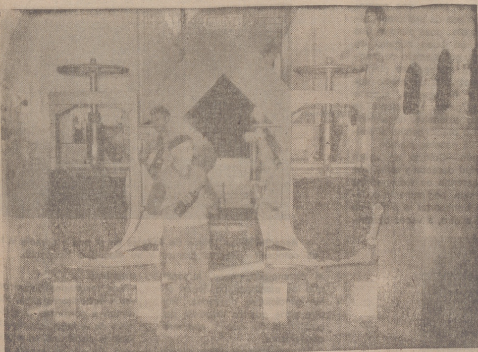
AUTOL. --- Vista de las dos prensas del equipo trabajando. El bodeguero, dispuesto a celebrar las ventajas del nuevo proceso.
