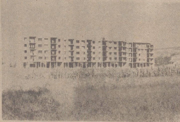
FUENMAYOR: 224 viviendas se han construido en los últimos cinco años
