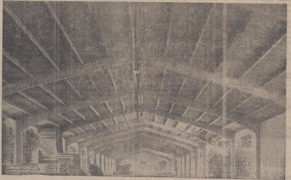
Pórticos de 8 a 20 mts. de anchura y de 2'50 a 6 mts. de altura en pilares; enteramente de hormigón, incluidos pilares,
