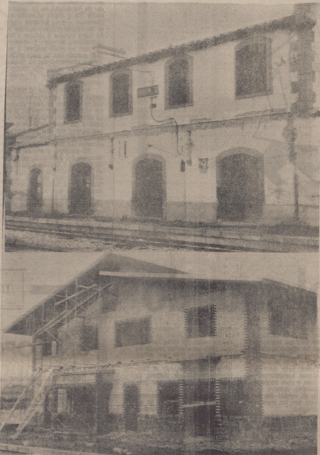
En la fotografía se puede observar, arriba, la estación que actualmente presta servicio y abajo, la que va a ser inaugurada en cuanto se termine que, como ven, no está a falta de mucho. Y el señor Ero dice que la han cerrado...
