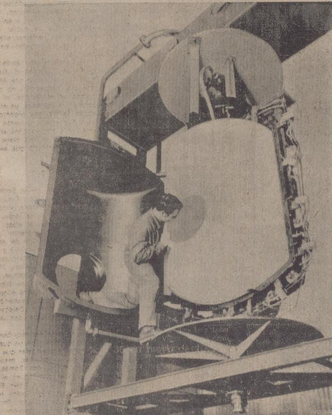
MUNICH (DaD). — Es ésta la máquina rotatoria de fundición más grande de Europa para la fabricación automática de cuerpos huecos de plástico sin costura. Mediante el nuevo procedimiento de producción, que va penetrando en el mercado, se pueden fabricar, en una sola fase de operación, tanques
