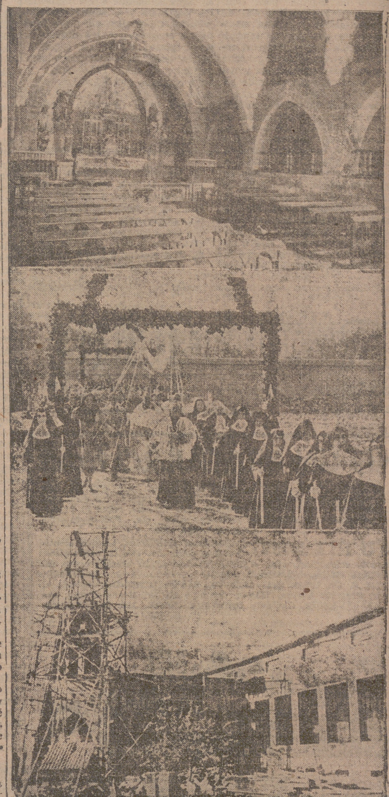
Vista de la nueva capilla. — Un detalle de la procesión eucarística celebrada por la huerta. — Estado de las obras de la torre. (Fotos y grabado Cortés-Paya)
