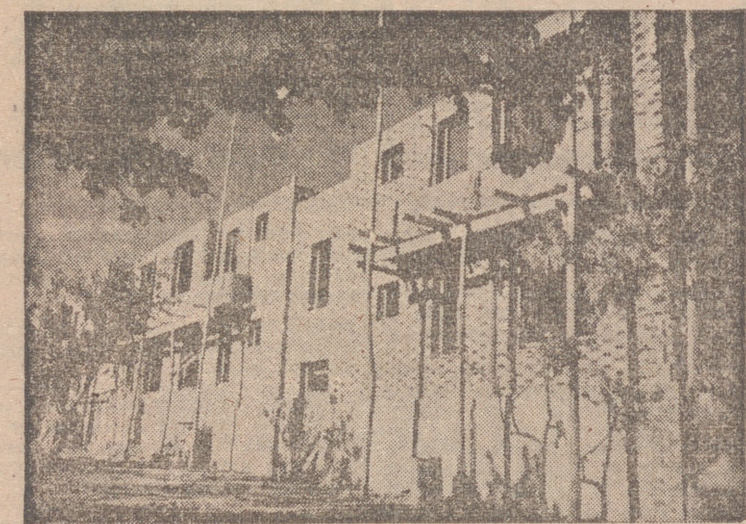
GRUPO DE 52 VIVIENDAS PROYECTADAS QUE ACTUALMENTE SE CONSTRUYEN EN ARNEDO
