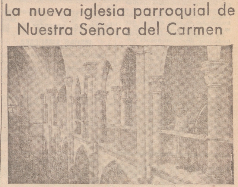
Las obras van a marcha vertiginosa, pero bien controlada. Ahí están atentos a todos los detalles el contratista y el Hermano Andrés, humilde y activísimo. Y así desde que se puso la primera piedra. ¡Cuánto debemos al sacrificio y laborioso Hermanito!
