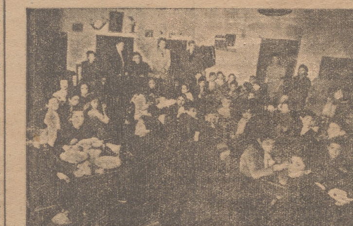
La Cantina Escolar de las Escuelas del Patronato «San Bernabé»
