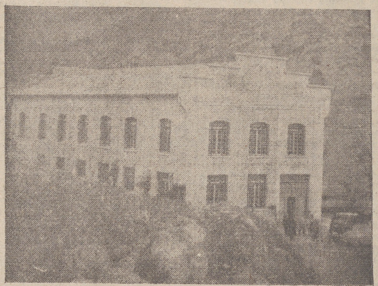
Casa de máquinas de «Saltos del Najerilla»
