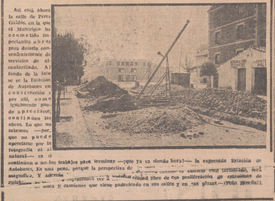
Así está ahora la calle de Pérez Galdós, en la que el Municipio ha acometido importantes obras para dotarla convenientemente de servicios de alcantarillado. Al fondo de la foto se ve la Estación de Autobuses en construcción y por allí, como igualmente puede apreciarse, continúan las obras. Lo que no sabemos —por que no puede apreciarse por la fotografía ni al natural— es si continúan o no los trabajos para terminar —que ya va siendo hora!— la expresada Estación de Autobuses. Es una pena, porque la perspectiva de una magnífica y además moderna ciudad libre de esa proliferación de estaciones de autobuses y camiones que viene padeciendo en sus calles y en sus plazas.—(Foto Euzkadi).
