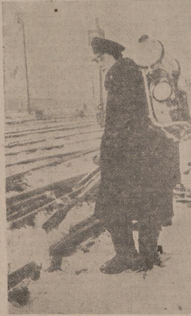
Aparatos lanzallamas para limpiar de hielo las vías de los ferrocarriles alemanes
